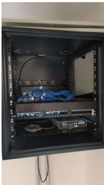
Instalação de rack e patch panel, com identificação OBRIGATÓRIA de cabos
